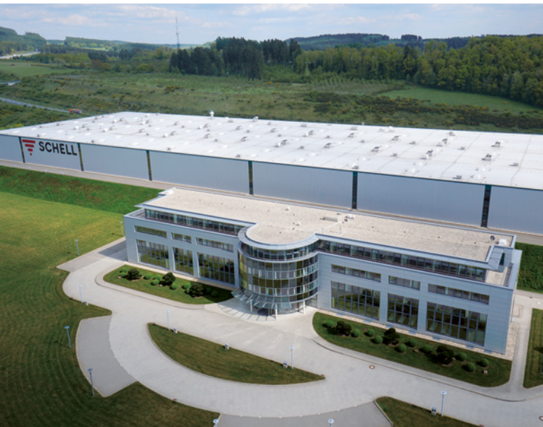
Fabriek 1 Productie met administratief gebouw en opleidingscentrum
